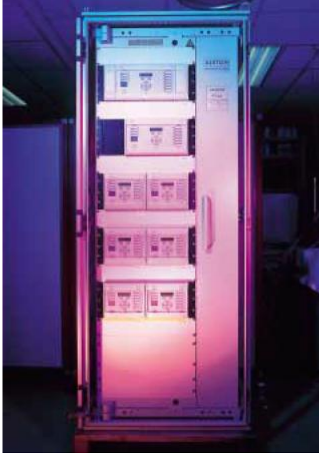
صورة 2-7 شكل الـ Relay المستخدم فى وقاية الـ BB
