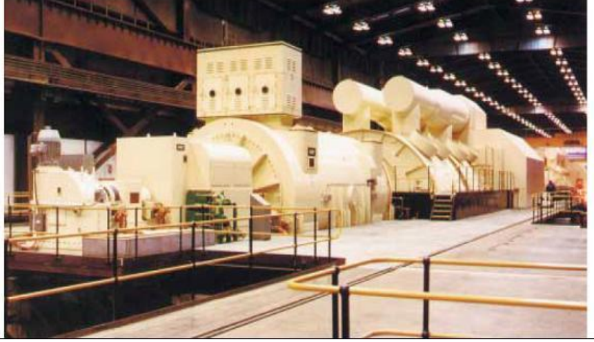
صورة 6-1 الشكل الحقيقي لمجموعة التوليد
