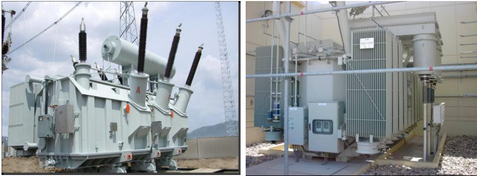
صورة 1-5 : محولات القوى (الأيمن معزول بـ SF6 الأيسر معزول بالزيت)
